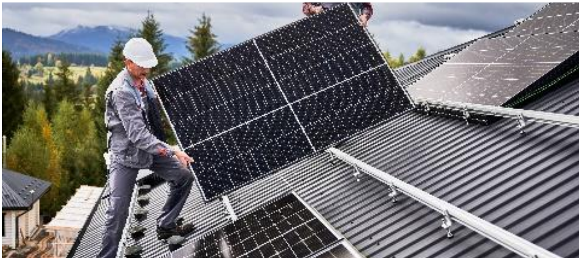
Installation von PV-Modulen (Bild: stock.adobe.com – anatoliy_gleb)
