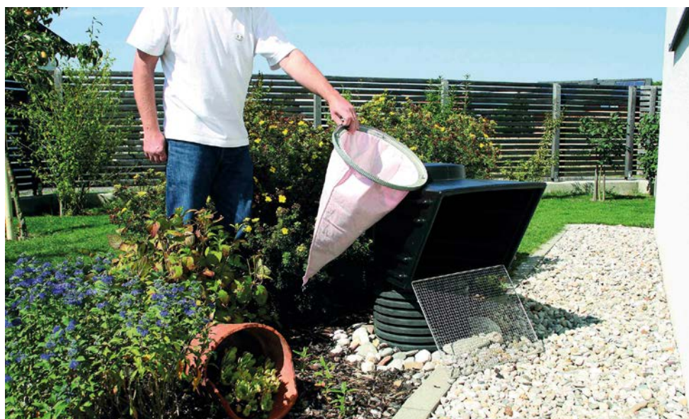
Abbildung 8: Wechsel eines Taschenfilters bei einer Außenluftansaugung Foto: Michaela Smertnig
